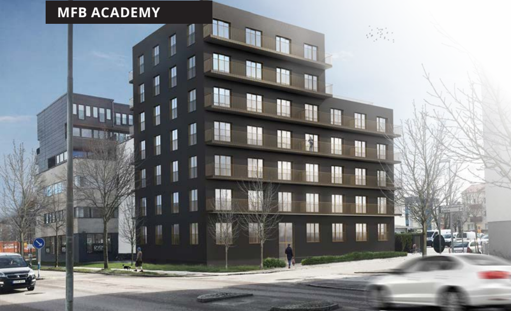
S:t Ilian-huset i Norrköping som byggs av Grönbo.
